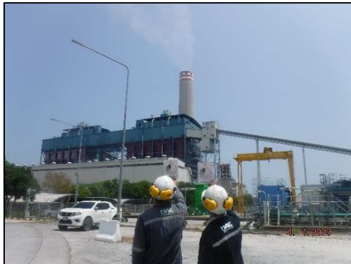
รูปที่ 3-6 การติดตามตรวจสอบค่าความทึบแสงของเขม่าควัน ที่ระบายออกจากปล่องระบายมลสารของโรงไฟฟ้า หน่วยผลิตที่ 1 เมื่อวันที่ 4 เมษายน พ.ศ. 2566
