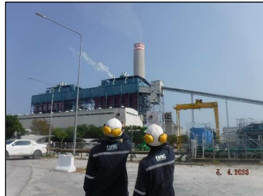
รูปที่ 3-7 การติดตามตรวจสอบค่าความทึบแสงของเขม่าควัน ที่ระบายออกจากปล่องระบายมลสารของโรงไฟฟ้า หน่วยผลิตที่ 2 เมื่อวันที่ 5 เมษายน พ.ศ. 2566
